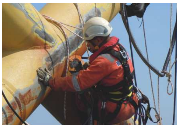
Bristle Blaster® na platformie morskiej
